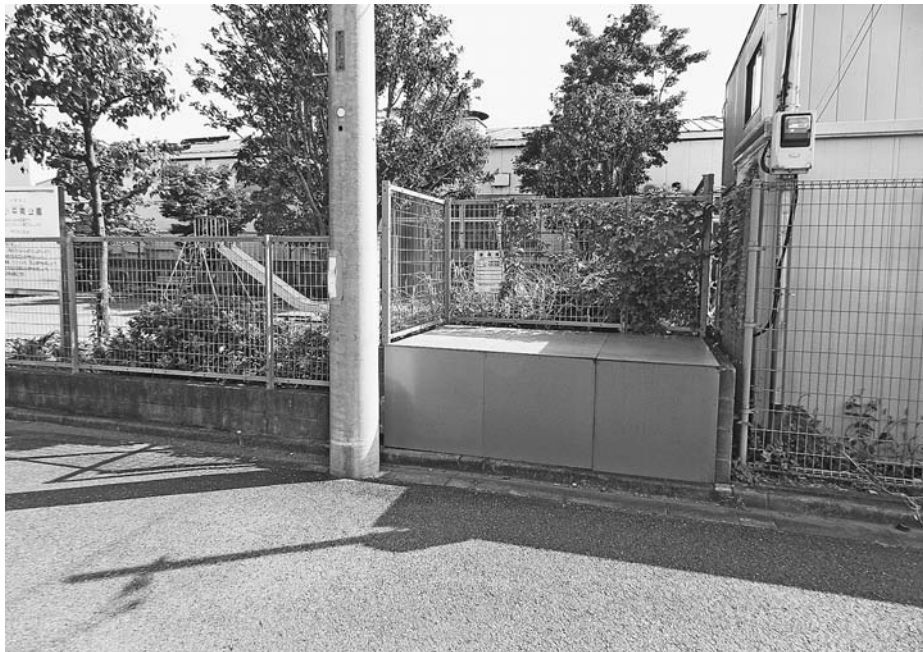
コンクリートパネルで塞ぐ処置がされたごみ集積所跡地（新小平東公園）
