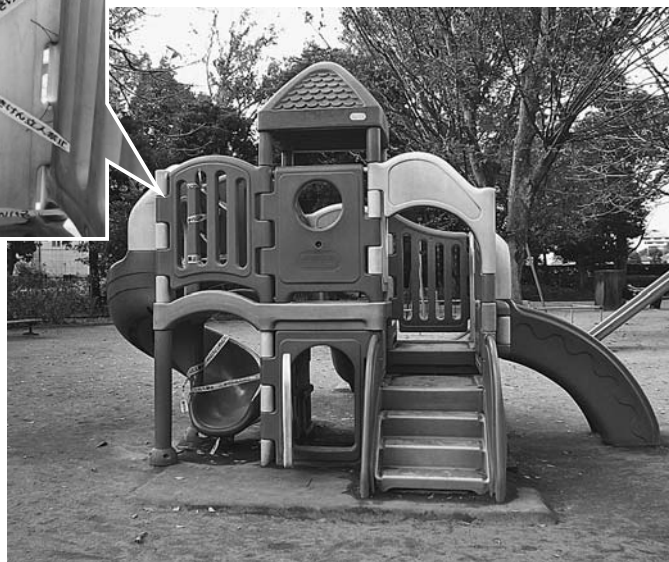
破損部を閉鎖した東部公園の遊具
