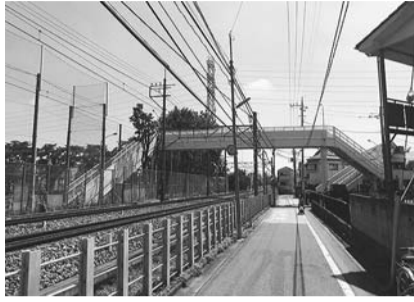
花小金井小学校校庭にかかる跨線橋
