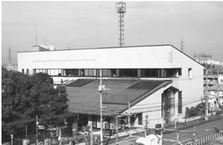
中央図書館に新しく設置された太陽光発電設備
